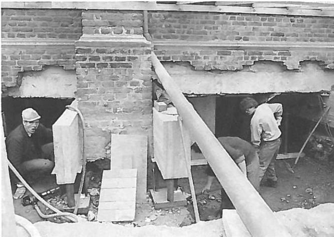
Oben: Ausschachtung unterhalb der Gnadenkapelle. Der Stahlbetonfundamentbalken unterhalb der Außenwände ruht auf Stahlprofilen, die mit Hydraulikpumpen gerade einjustiert werden. Die Verpreßpfähle fangen die Lasten ab (26.3.91)
