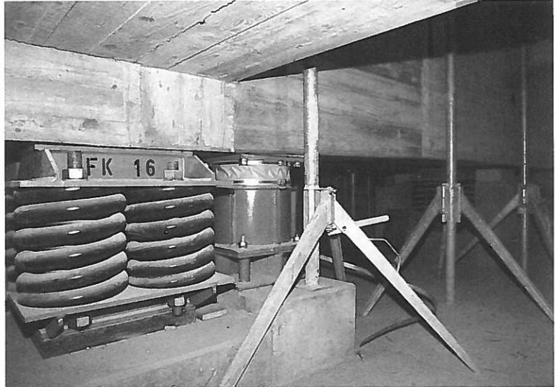
Selbständig arbeitende Federelemente unter dem Balkenrost gleichen künftige Bodensetzungen aus. Foto: Rheinbraun
