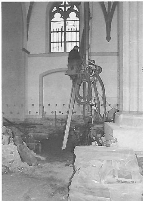
Unten: Maschine zum Einbringen der Verpreßpfähle, hier für die Spundwand östlich des Turmes (29.5.90)
