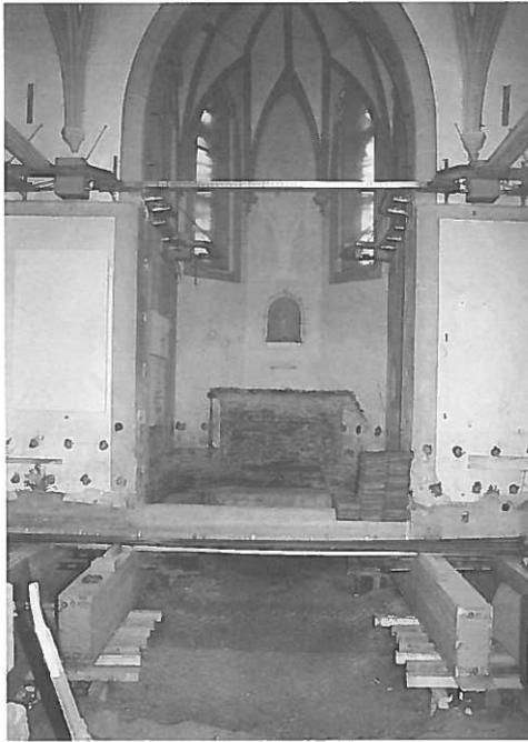
Oben: Blick vom Mittelschiff in die Gnadenkapelle. Ein Teil der Querträger und die Abfangung des Mauerwerkes sind schon betoniert (25.1.91)
